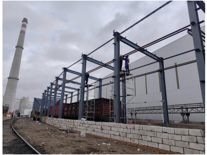
Гэсгээх барилгын дулааны хоолойн угсралт
