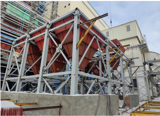
Уутат шүүлтүүрийн үнсний бункер суурилуулалт
