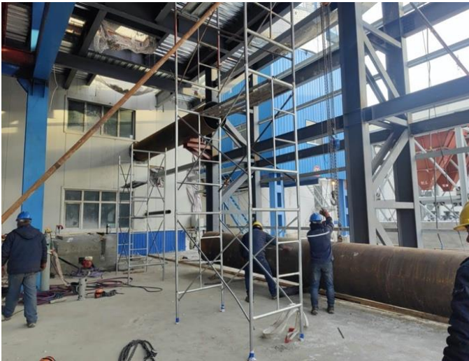
Зуухны өгөх усны хоолойн угсралт
